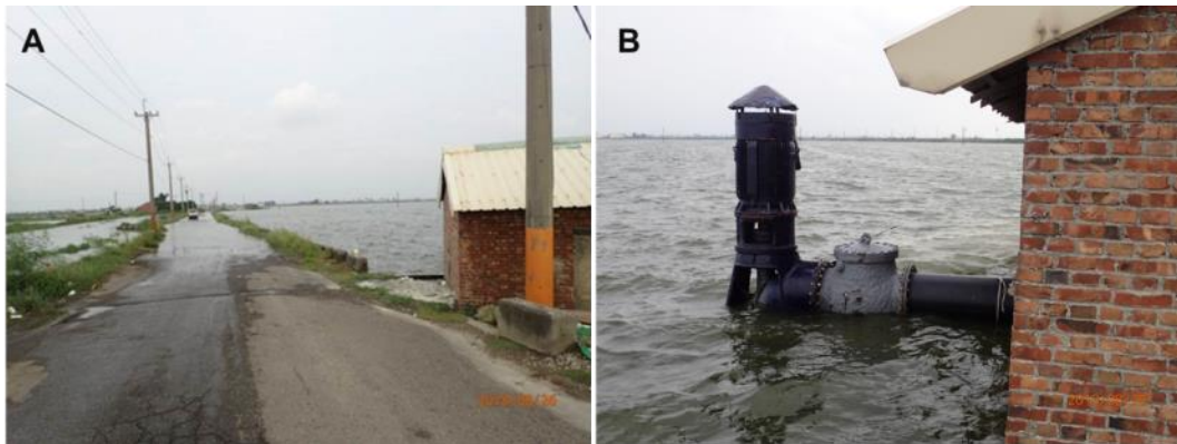
圖 4-6、107 年 8 月 23 日布袋地區大雨後的情形 A.嘉 30 公路，B.新岑 1 號抽水站
