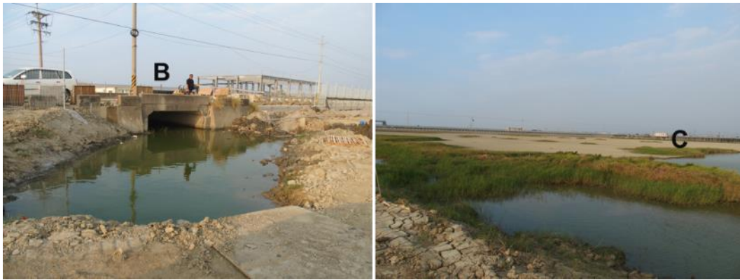
圖 4-2、嘉 30 公路東側的箱涵，(B)路下方的箱涵、(C)路南邊的灘地
