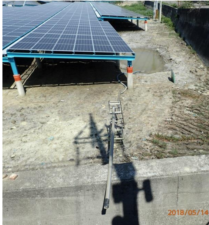
圖 4-1、光電設置區施工時抽乾，但完工後地表乾燥易產生揚塵。
