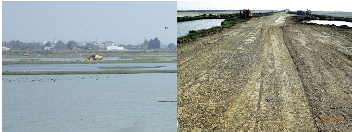
圖 4-3、壓路機將中央的產業道路整平壓實(2018/12/13 上午)
