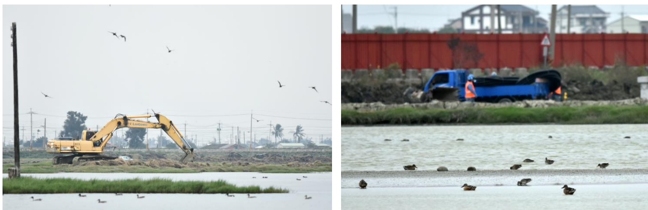
圖 22. 復育區內停棲的水鳥與施工中的車輛
